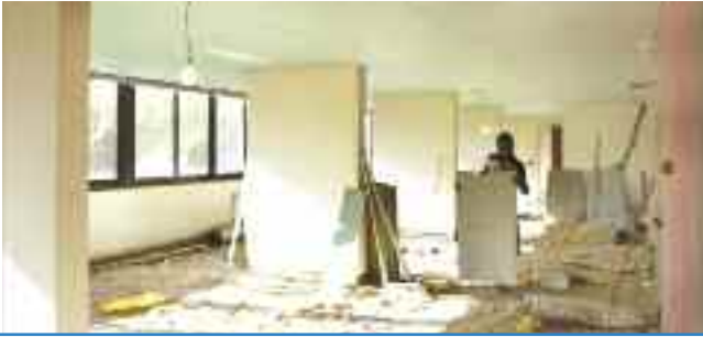
ورشة إعادة تأهيل قاعة الكافيتيريا في الطابق الأول من مبنى المعهد
